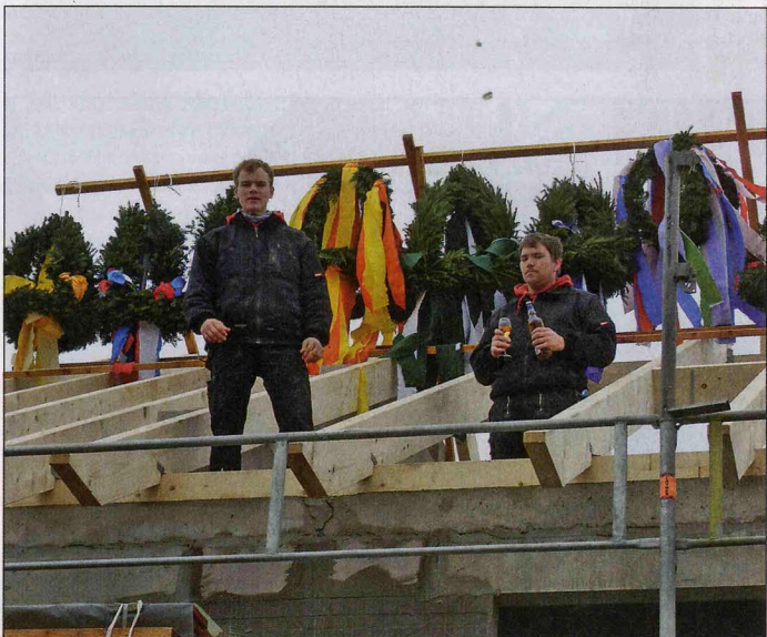
Richtfest wurde am vergangenen Freitag auf der Baustelle im Kiarwai 4a gefeiert. Dort entstehen für den Bauherrn RT-Immobilien insgesamt 22 Ein- bis Dreizimmerwohnungen in einem ästhetisch ansprechenden Gebäude.
