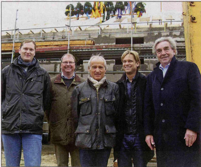
Glückliche Gesichter am Tag des Richtfestes (v.l.): Bauleiter Sven Venz von der Firma Ohlms – die Profis rund ums Bauen; Hanjo-Wulf Paeske, Geschäftsführer von RT-Immobilien; Andreas Ohlms, geschäftsführender Gesellschafter der Firma Ohlms, Christoph Thomsen vom Sylter Architektur-Büro Hans Georg Thomsen sowie Bauherr und RT-Geschäftsführer Reinhard Tiesel. Fotos: Heiko Wiegand
